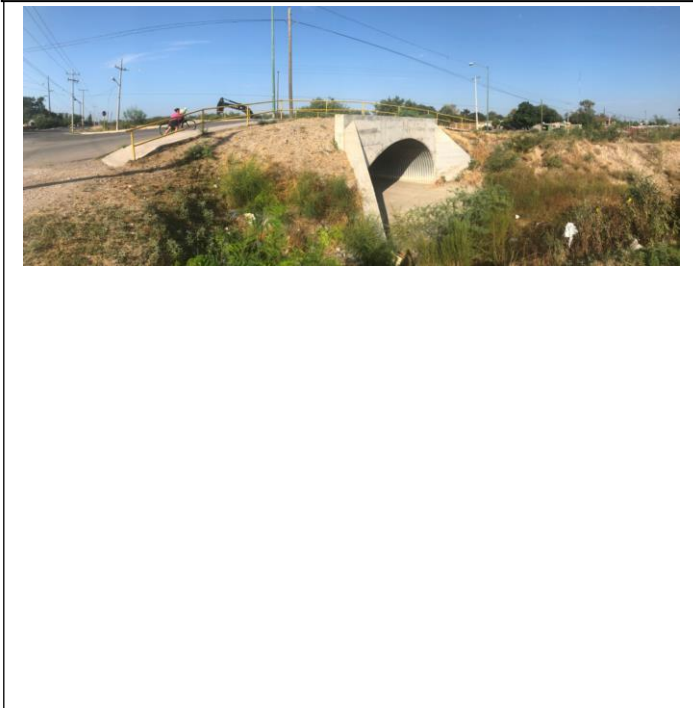
Puente Juaristi: Vista lateral del puente azolvado (la maleza es muy abundante)
