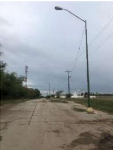
Vado Viejo al Moral: vado vehicular en regulares condiciones, IRI de 6
