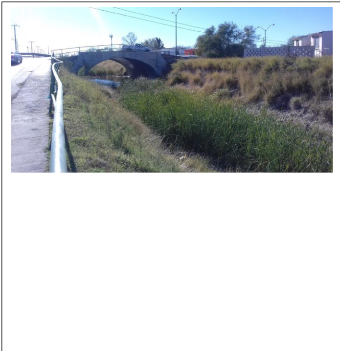
Puente Prol. Cepeda: Vista lateral del puente azolvado (la maleza es muy abundante)
